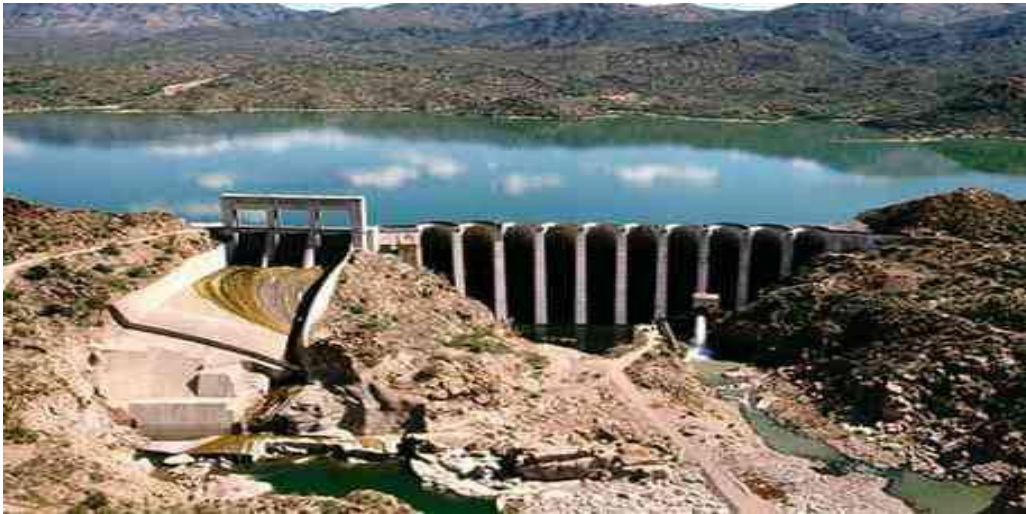
الشكل (-) يوضح جسم سد خرساني مدعم
