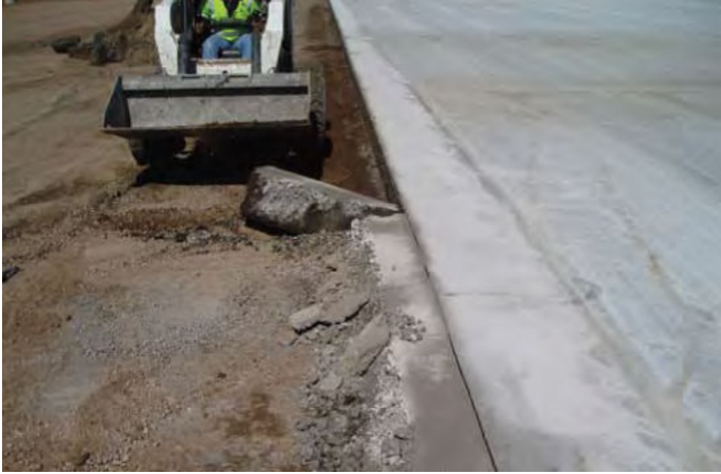
الصورة توضح كيفية القطع لانشاء فاصل بارد
