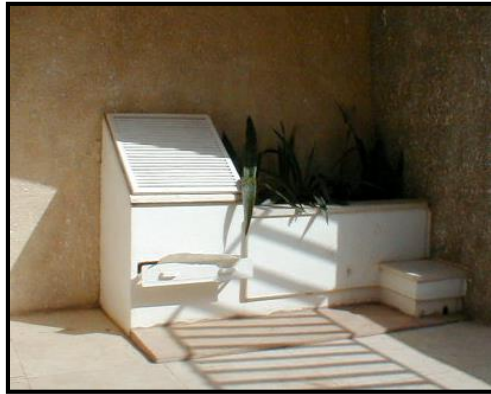
شكل (٣-٢٥) يوضح استخدام الملقف بالمبنى المصدر: د. عثمان الخير
