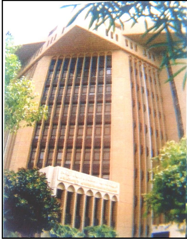
شكل (٣-٩) يوضح نموذج لاستخدام كاسرات الشمس الرأسية
