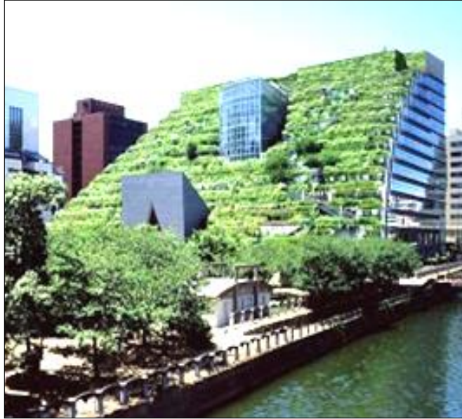
شكل (٣-٤) يوضح استخدام الحوائق السطحية لتظليل الأسقف (عالم الكهرباء و الطاقة ٢٠١٣)
