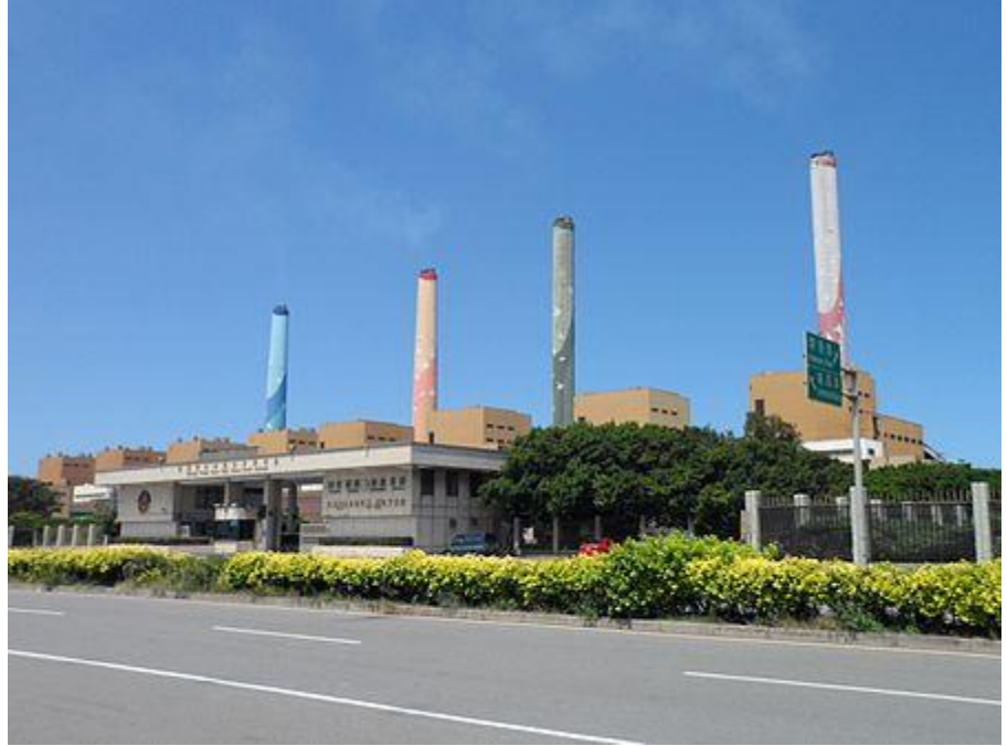
تايشونغ، هي أكبر محطة توليد طاقة تعمل بالفحم، بقدرة ٧,٤٢٤ ميغاواط
