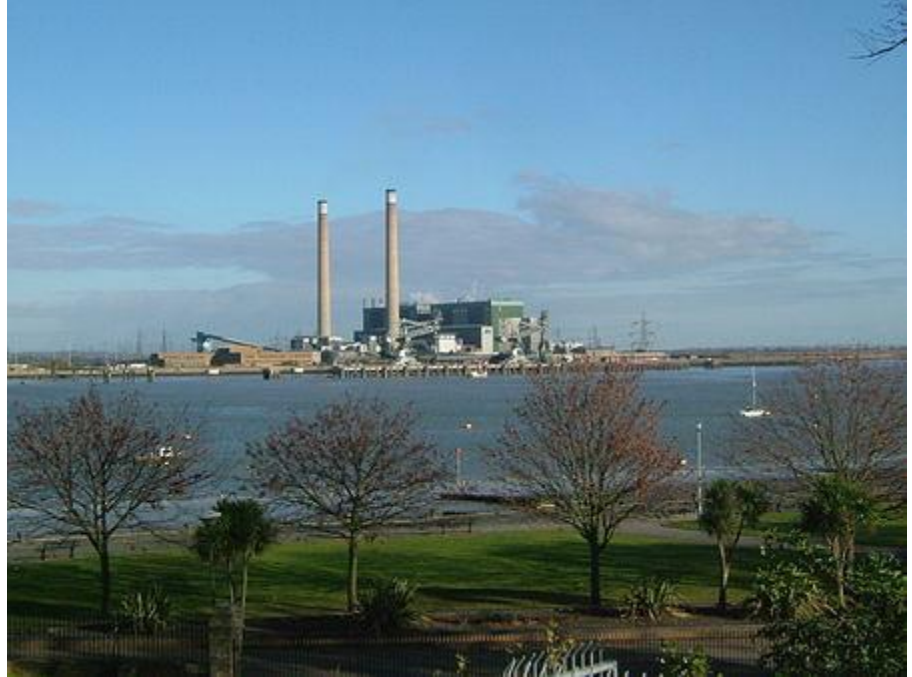
منذ عام ٢٠١١ ، ومحطة تيلبوري بي للطاقة، تعد أكبر محطة توليد طاقة تعمل بالوقود الحيوي وبقدرة ٧٥٠ ميغا واط
