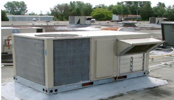
وحدة مناولة سطح علوي RTU
