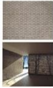
الألياف الزجاجية وتقنية الثقوب الصغيرة في الخرسانة الشفافة
