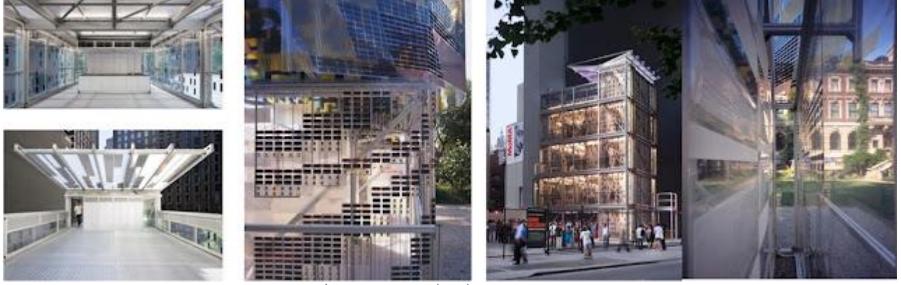
مبنى Cellophane House في متحف الفن الحديث في نيويورك بغلاف من مادة Smart Wrap
