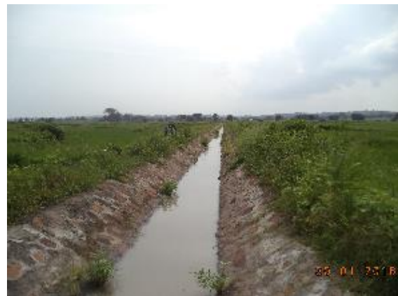
Masonry lining canal (Buhekela, Igunga, Tabora)
