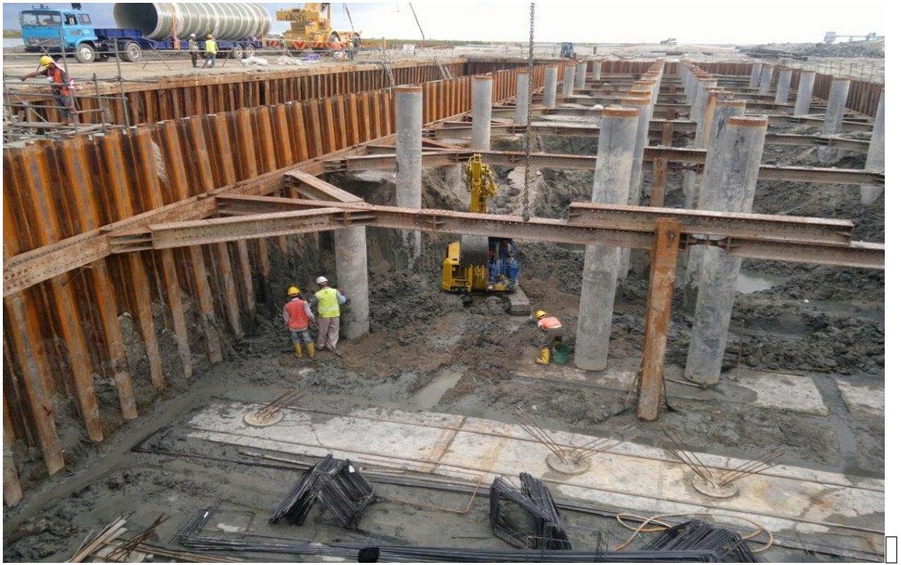
وینہی ژماره (5) له پروژه که دا شیت پایل و کونکریت پایل جیبه جی کراوه
