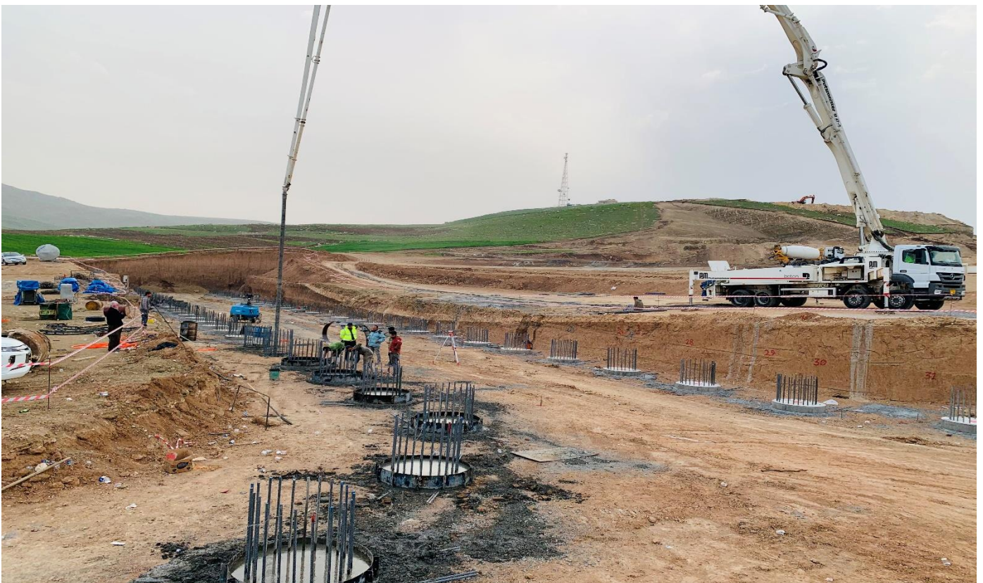
وېنەى ژمارە(1) پايەل فاوندەيشن لە يەكئەك لە ئەندەرپاسەكانى شەقامى 100م سلېمانى
