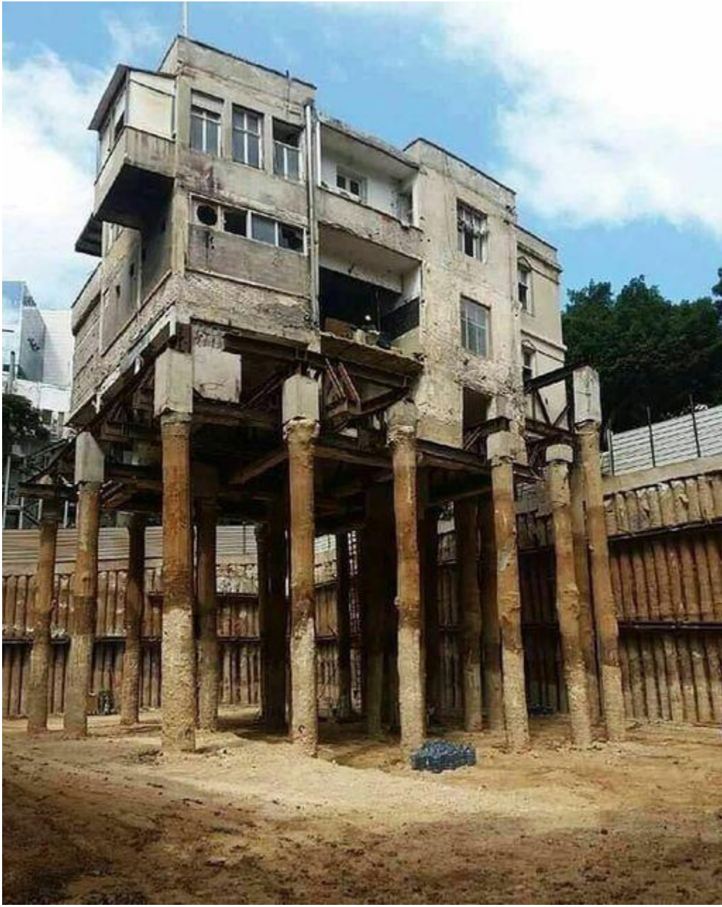
وینہی ژماره (4) پایله فاوندهیشن دروستکراوه وهك بناغه بۆ بالهخانهیهك
