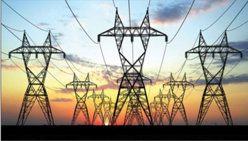
لا بد وأن تكون محطات توليد الطاقة الكهربائية لأسباب فنية واقتصادية بالقرب من مصادر الوقود (نפט، فحم حجري، غاز، أو مساقط المياه) وبالقرب من مخزون مائي كبير (نهر أو بحيرة) لتأمين تبريد محطة التوليد. ولهذه الأسباب تكون محطات التوليد بعيدة عن مناطق الاستهلاك. والشبكات الكهربائية هي العنصر الذي يربط بين محطات التوليد والمستهلكين.
