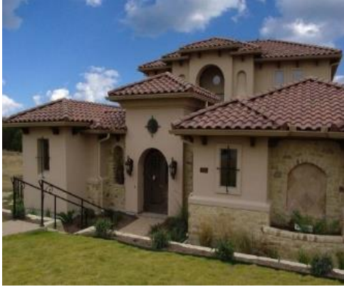
صورة 12 توضح تكرار استخدام المرسلية في اسقف المبنى
