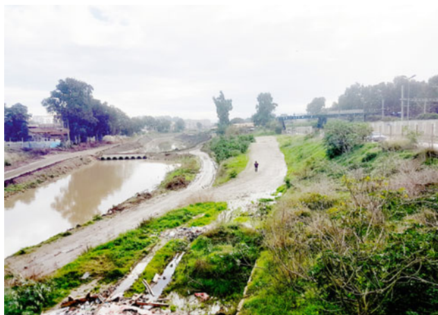
Fig. 6 Picture Highway bridge to Dar El Bei
