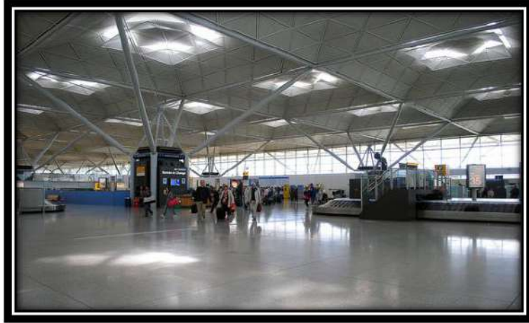
شكل (3-39) مبنى عميق من طابق واحد في مطار ستانستيد يسمح بانارة الداخل بأكمله بضوء النهار من السقف الذي صمم بعناية (المصدر السابق ص 26)
