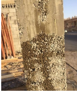
الشكل رقم ( 2 ) يوضح الانفصال الحبيبي لعمود بارترقاغ ( 3 ) امتار
