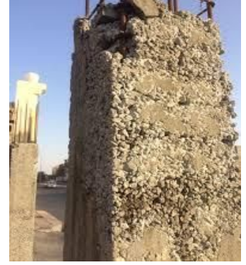
الشكل رقم (1) يوضح الانفصال الحبيبي لعمود
