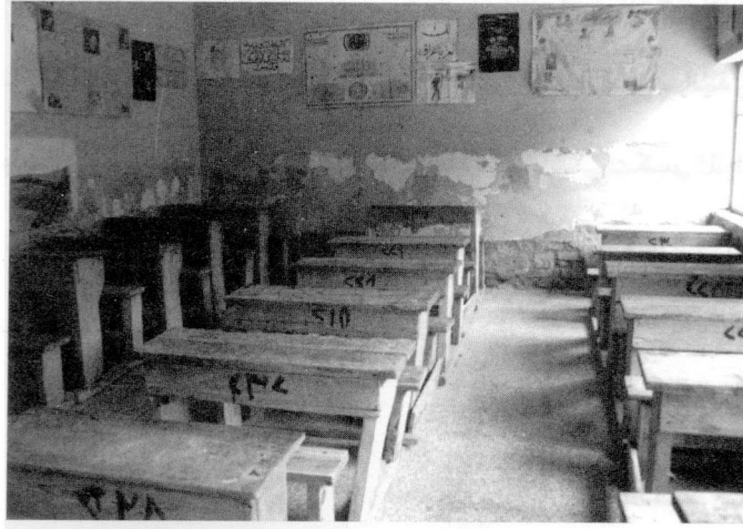
(شكل رقم ٢ - ٣) تصدع الورقة بسبب الرطوبة
