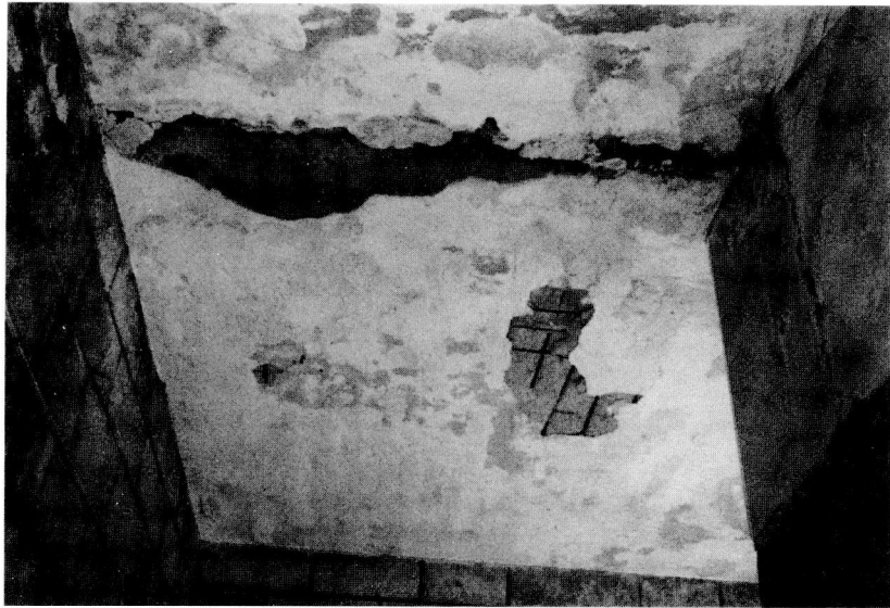
(شكل رقم ٢ - ١) تصدع الخرسانة بسبب التكرين
