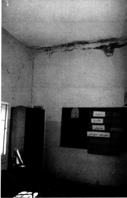
(شكل رقم ٥-٦) انتفاخ الورقة بسبب تسرب الرطوبة من السطح
