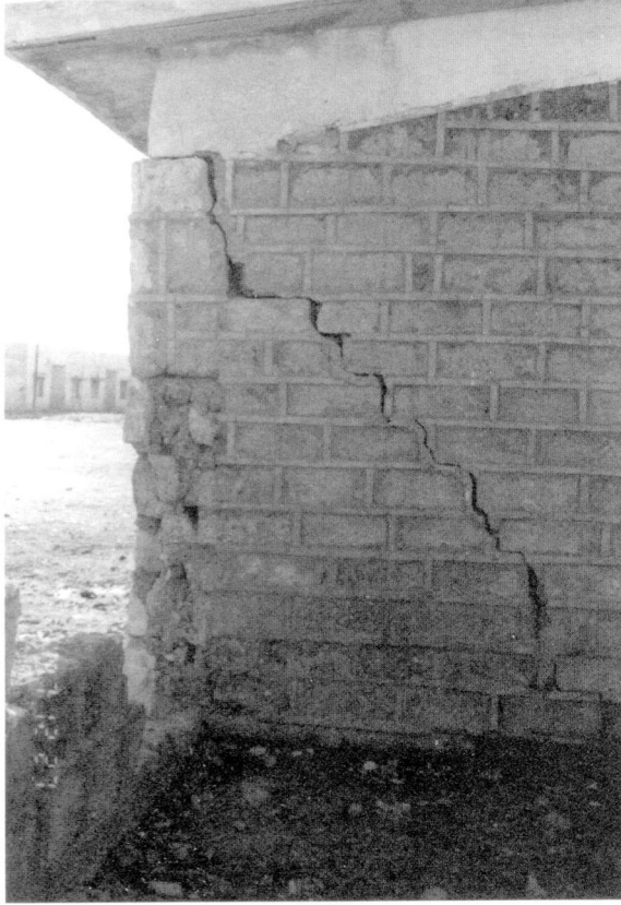
(شكل رقم ٩-٢) شروخ مائل حدث بعد هبوط الاساسات بسبب خلل في التربة
