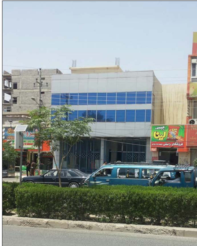
نموذج رقم ( ٢ ) استخدام المواد المركبة على مستوى مبنى كامل
