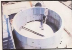
حلقهات خرسانیه ذات تجویف بقطر ۸.۳۵ متر (مترو انفاق القاهره)
