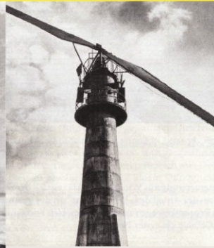
Smidth „Aeromotor“ 1941 & 1942: 50kW
